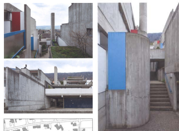
Adresse: Schauenburgstrasse 6a-6d, 8a-e, 10a-10e Bauzeit: 1969-1971 Architekt: Hans Rudolf Bader, Solothurn Bauherrschaft: unklar Literatur: Habitat/Innov. Spec. Vol. I, 1979, S. A133-136, – Almanach 1981, o.S. – Merkt/Hofmarcher 1998, Nr. 29, – Wächter 2005, S. 158-159
