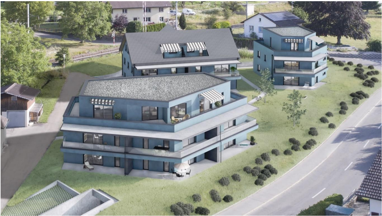
... und so wird er sich nach der Fertigstellung präsentieren.
